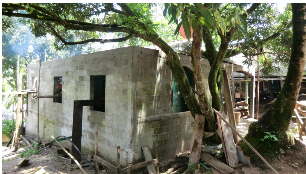
Ilustración 2 - Proceso de transformación de casa hecha de madera a mampostería de cemento. Foto tomada por Edwin Matamoros Ch. - Rama Cay 2013
